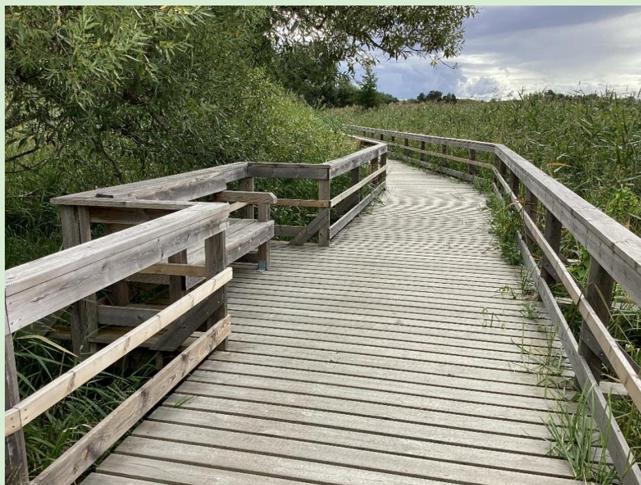
Figur 2. Exempel på hur en spång skulle kunna utformas. Ett trädäck med räcken, upphöjd från vattenytan, grundad med pålar. Bilden är från Ekolsnäs i Uppsala.
